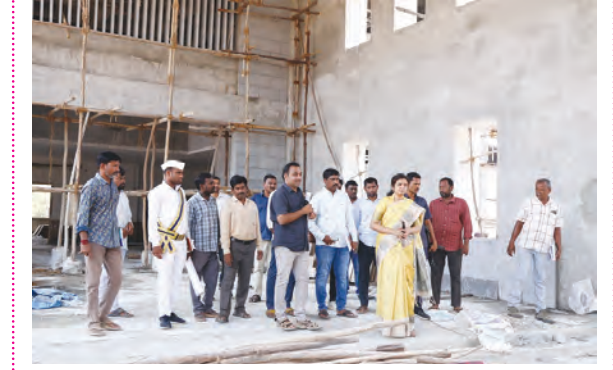
నూతన కలెక్టరేట్ భవన నిర్మాణ పనులు పం.కీరిమ్మన్, కలెక్టర్
